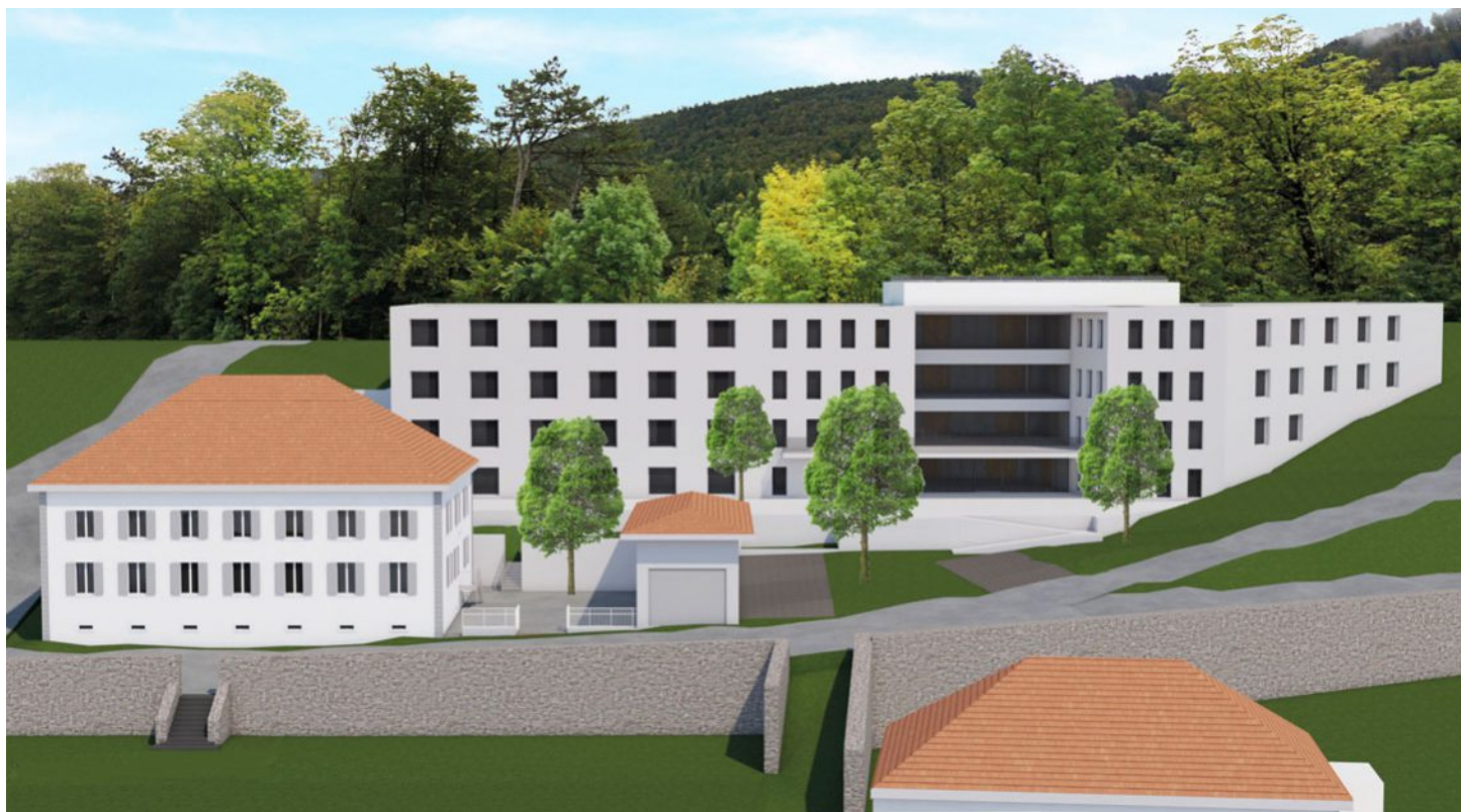
La Maison de l'autisme, conçue par le bureau Viret architectes SA, sera construite sur une parcelle mise à disposition par La Pimpinière, à Saint-Imier, en bordure de forêt, proche du funiculaire. Le budget de sa construction s'élève à 15 millions de francs. EPSILUS/VIRET ARCHITECTES SA
